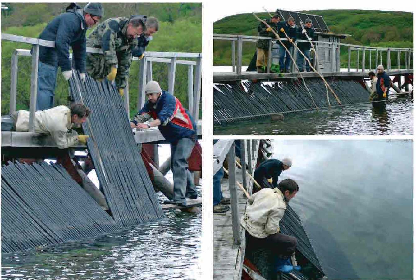
Рис. 111. Установка рыбоучетного заграждения (19–20 июня 2007 г.)
