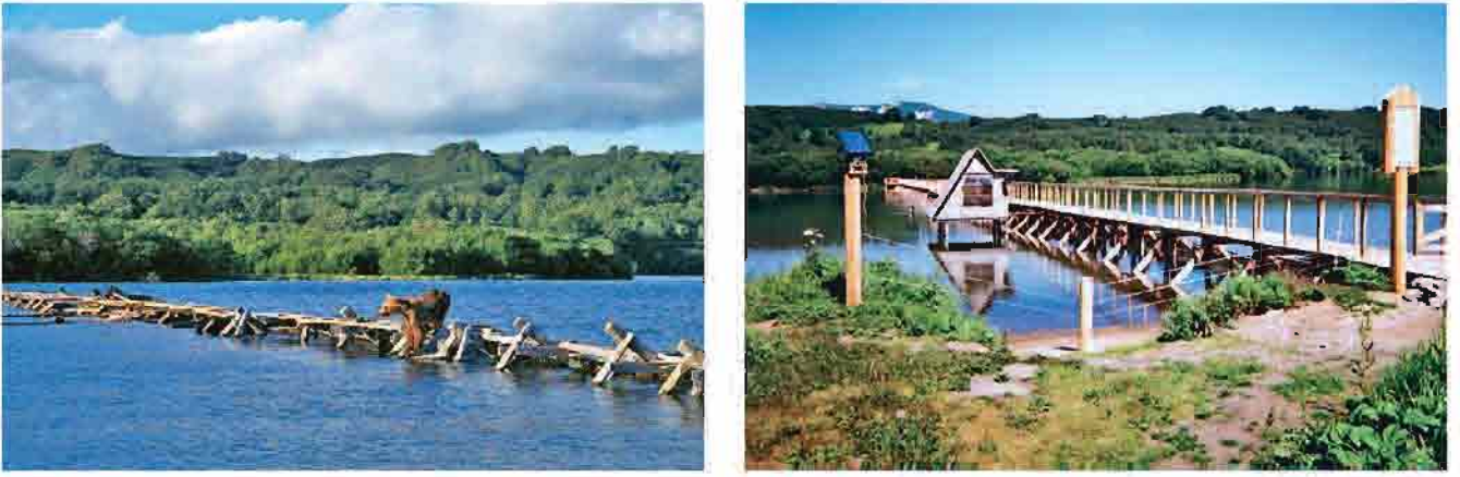
Рис. 40. Старое (слева) и новое (справа) рыбоуловное заграждение на Озерновском наблюдательном пункте, построенное в июне 1999 г. для подсчета численности нерки, пропущенной в оз. Курильское на нерест
