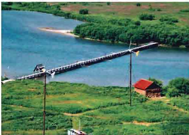
Рис. 109. Новое рыбоучетное ограждение на Озерновском наблюдательном пункте построено в июне 1999 г. для подсчета численности нерки, пропущенной в оз. Курильское на нерест (слева – июль 2003 г., фото Е. А. Шевлякова,; справа – июль 2003 г., фото авторов)
